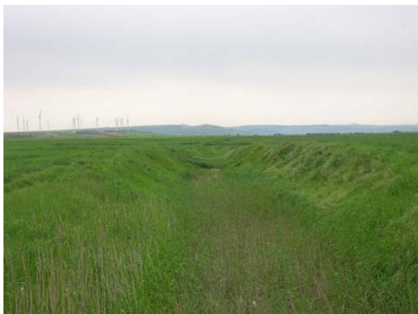
Foto 28 – Cigli del Canale Ponte Rotto
