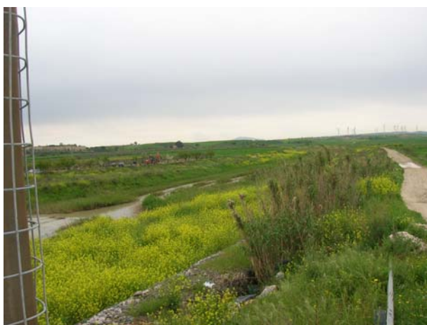
Foto 29 – Cigli del Torrente Carapelle caratterizzato da sistemazione idraulica
